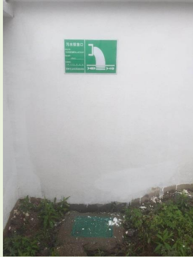
污水排放口及标识牌
